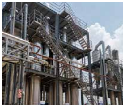
惠州湘澧化工有限公司 氯化铵废水 4t/h三效蒸发器（1套）
