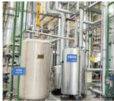
广州市环境技术设备有限公司 (广汽集团) 物化废水、焚烧废水 12t/h MVR 蒸发器 (1套) +12t/h三效蒸发器 (1套)
