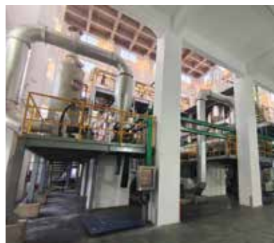
广东农海科技有限公司 海水淡化项目 3t/h MVR 蒸发器 (1套)
