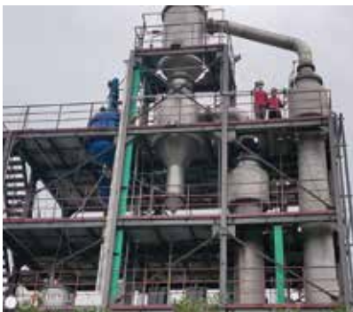
广东新盈信环保科技有限公司 催化剂再生利用废水处理 2t/h MVR 蒸发器（1套）
