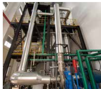
清远甲乙新材料有限公司 硫酸钠废水处理 6t/h MVR蒸发系统
